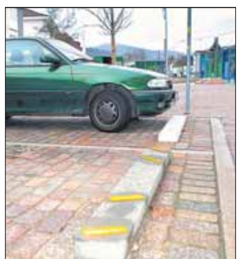
Die Begrenzungssteine am Bahnhofplatz werden von Fußgängern oft übersehen. Foto: Alex
